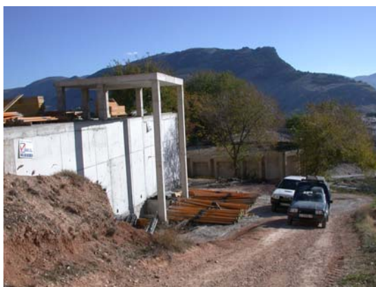
Nuevo depósito Alto Castillo
